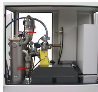
Equipo eléctrico estacionario con cubierta de protección
